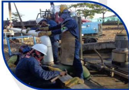
Prefabricación y montaje de tuberías
