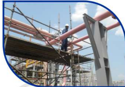
Prefabricación y montaje de tuberías
