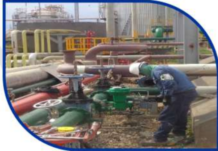
Montaje de válvulas de control
