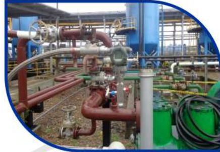
Instalación de transmisores de presión
