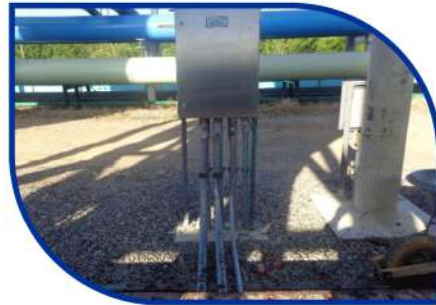
Instalación de transmisores de presión
